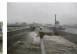
(排水分水ゲート)
