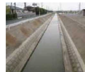
排水路の整備
