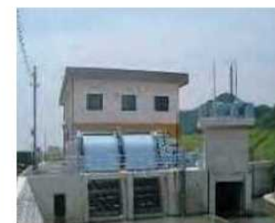
排水機場の整備
