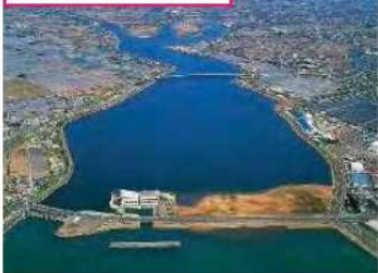
排水機場と周辺の市街地
