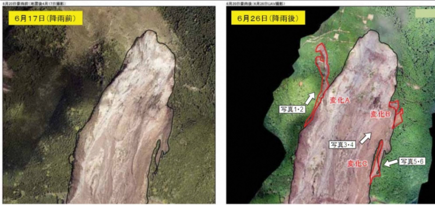
図 51 UAV 計測により土砂移動状況を把握した例
