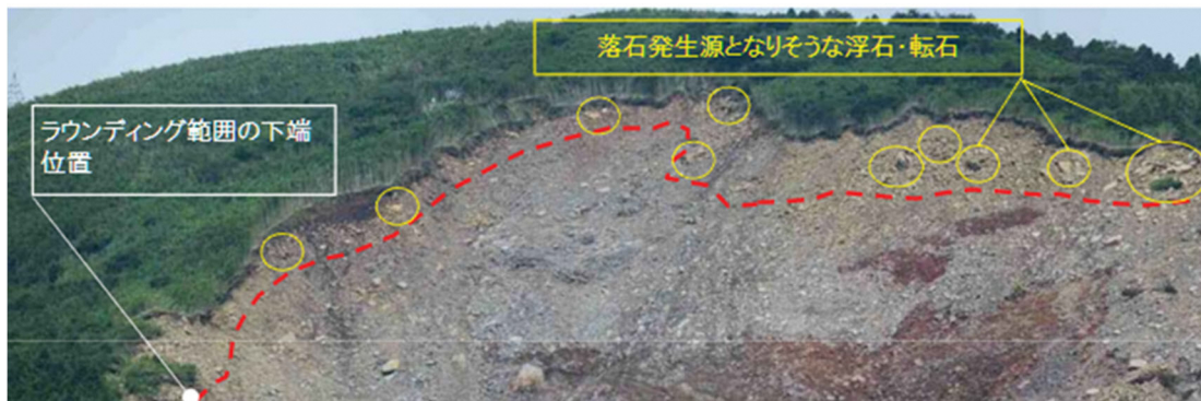
図 53 ラウンディング範囲と浮石の分布を確認し、頭部ラウンディング工の範囲を設定した例
