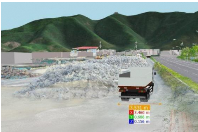
障害物との離隔確認
