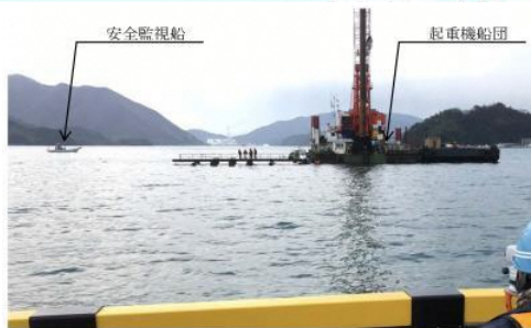
作業船の配置（上：3次元モデル計画、下：現地稼働状況）
