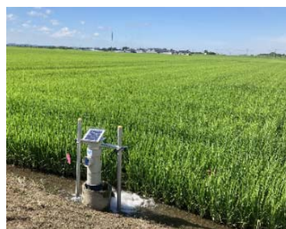
【自動給水栓の導入（鶴岡市）】
