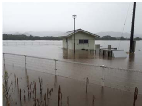
【揚水機場の浸水被害 (R2: 白鷹町)】
