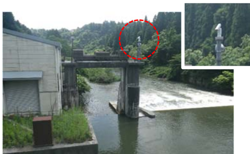
【西高峰頭首工の監視カメラ（飯豊町）】
