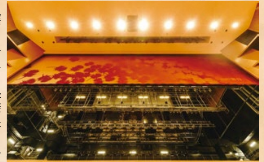
「奈落」から見上げる舞台上部の全容
