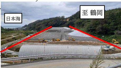
鼠ヶ関トンネル付近盛土区間
