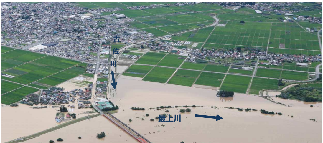
一級河川古佐川（令和2年7月浸水被害状況）
