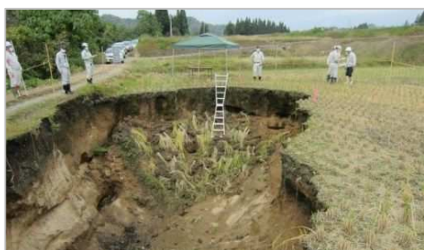
<令和2年発生 舟形町の大規模な陥没>
