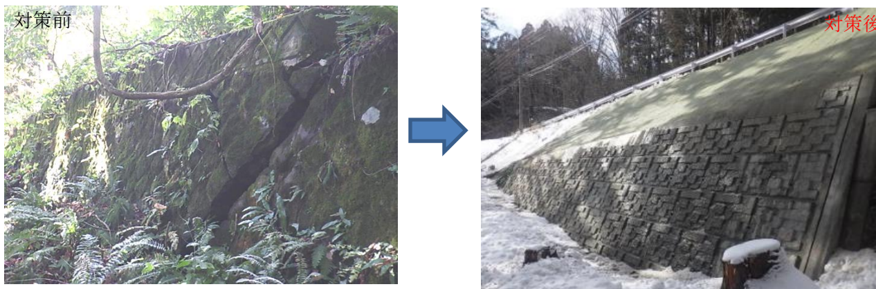
擁壁補修+上法面の植生を実施
