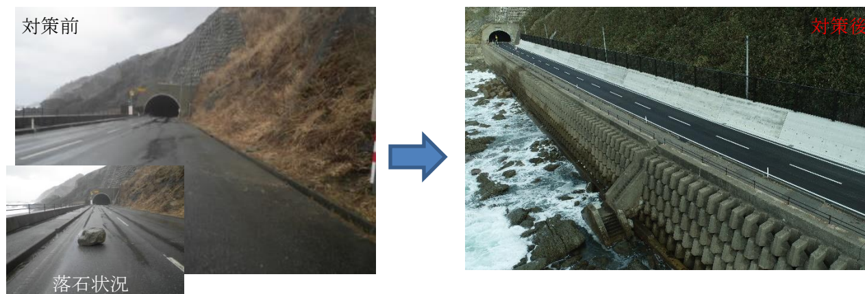
擁壁工+落石防護柵工を実施
