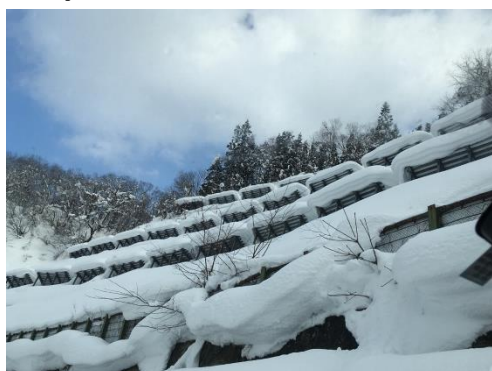
雪崩対策の例
