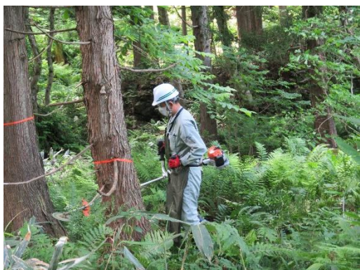
写真 8 カメラ設置箇所刈払い状況
