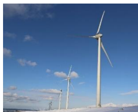
県営風力発電所
