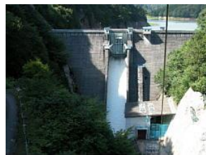
県営水力発電所(高坂ダム)
