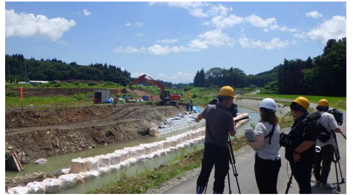
テレビ局による工事施工状況の取材
