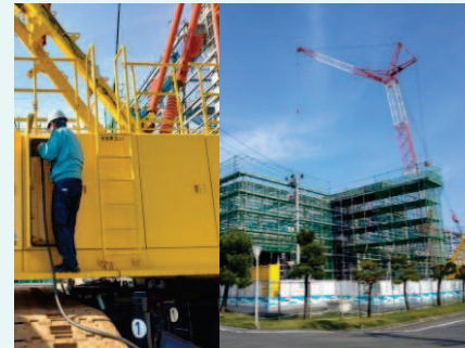
清水建設クローラークレーン
