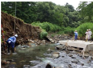
被災箇所の測量
