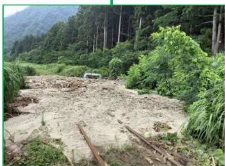
土砂流入 (越後片貝～越後金丸間)
