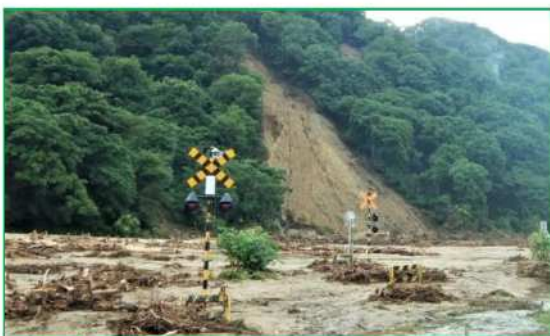
大規模土砂流入 (坂町～越後大島間)
