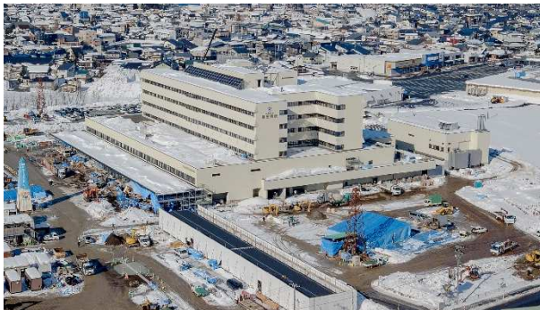
新病院 建設状況 (R5. 1. 19 撮影)
