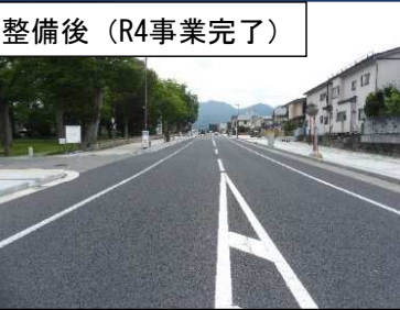
道路拡幅、無電柱化の例 四日町山家町線（山形市）
