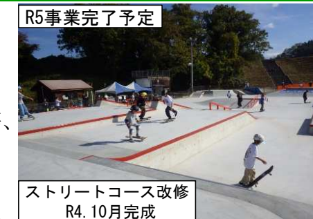
R5事業完了予定 ストリートコース改修 R4.10月完成 最上川ふるさと総合公園 スケートパークの更新（寒河江市）
