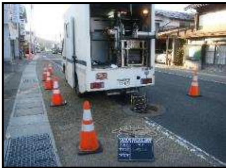
管渠点検調査 (テレビカメラ調査)
