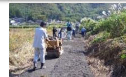
未舗装農道をアスファルトで舗装
