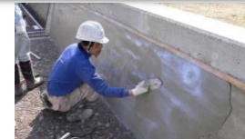
老朽化した水路壁のコーティング
