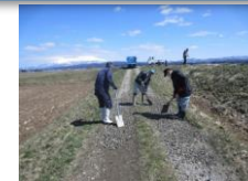
農道の路面補修
