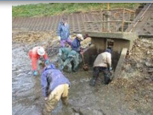
貯水機能発揮のため池浚渫
