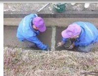
水路目地補修
