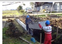
素掘水路からコンクリート水路へ更新
