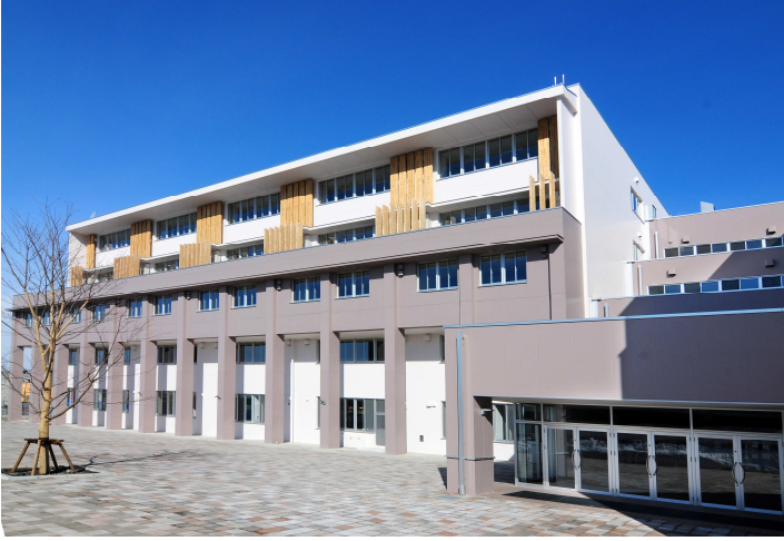
《校舎棟外観写真》
