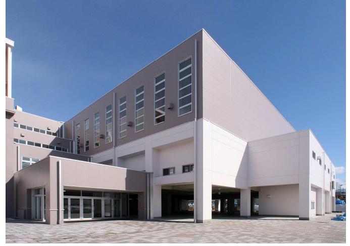
《体育館棟外観写真》
