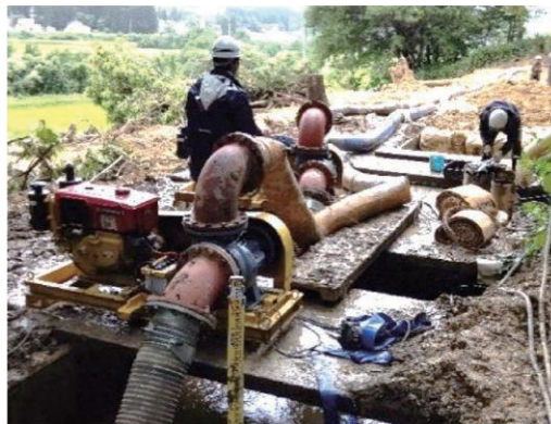
↑追加で手配したポンプを設置して取水開始（飯豊町）
