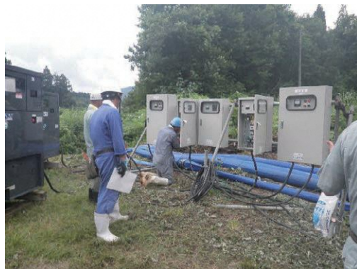
↑ ポンプで応急的に水路に通水（小国町）
