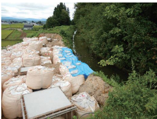
↑破損した水路を土のうとブルーシートで仮修復（川西町）
