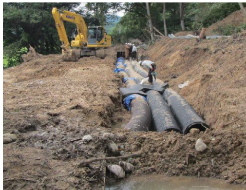
↑排水管を地中に埋設（飯豊町）
