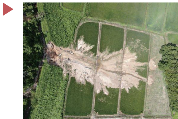
↑水路が破損し農地へ土砂が流入（川西町）
