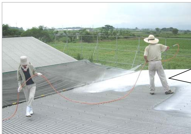
屋根への石灰の吹きつけ（宮崎県）
