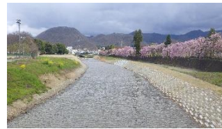
河川整備補助事業(防災・安全交付金) 「野呂川工区(山形市)」 完成 令和2年3月
