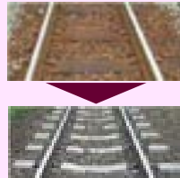
マクラギを木からコンクリートへ
