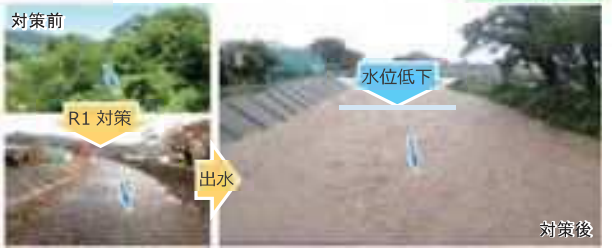
— 堆積土砂や支障木の撤去による効果 —
