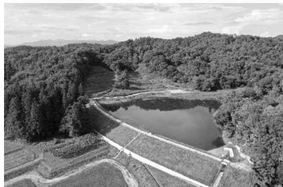
改修された農業用ため池
