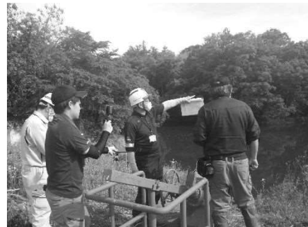
ICTを活用したため池点検
