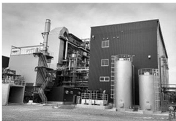
木質バイオマス発電施設
