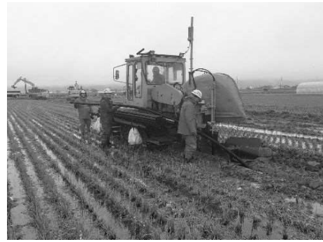
庄内町 地下かんがいの施工
