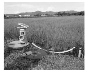
自動給水栓の実証試験
