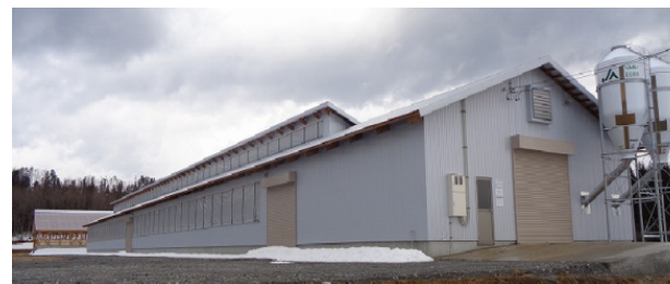
畜産クラスター事業でH30に整備した大規模肥育牛舎(真室川町)
