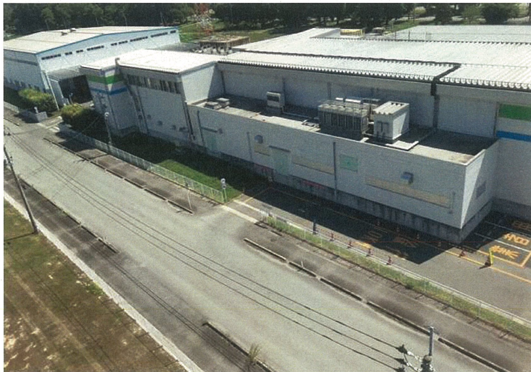
構内南東位置から東側を撮影
