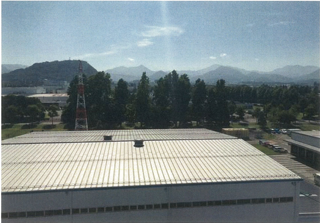
構内北東位置から東側を撮影
