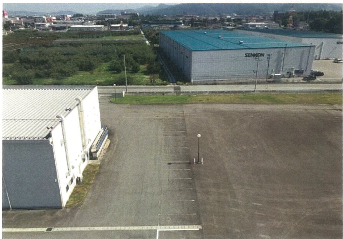
構内中央位置から北側を撮影
