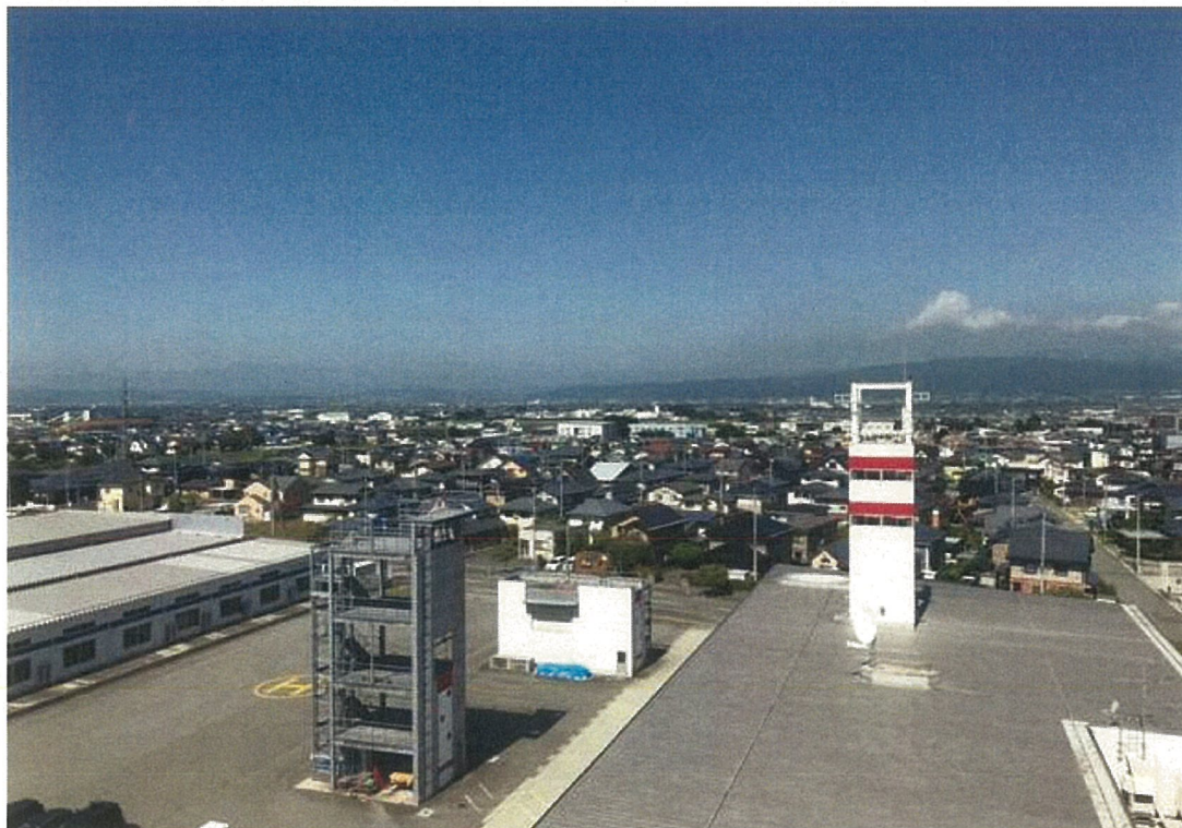
構内北西位置から西側を撮影
