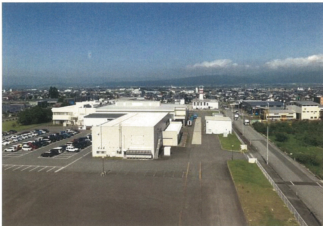
構内北東位置から西側を撮影
