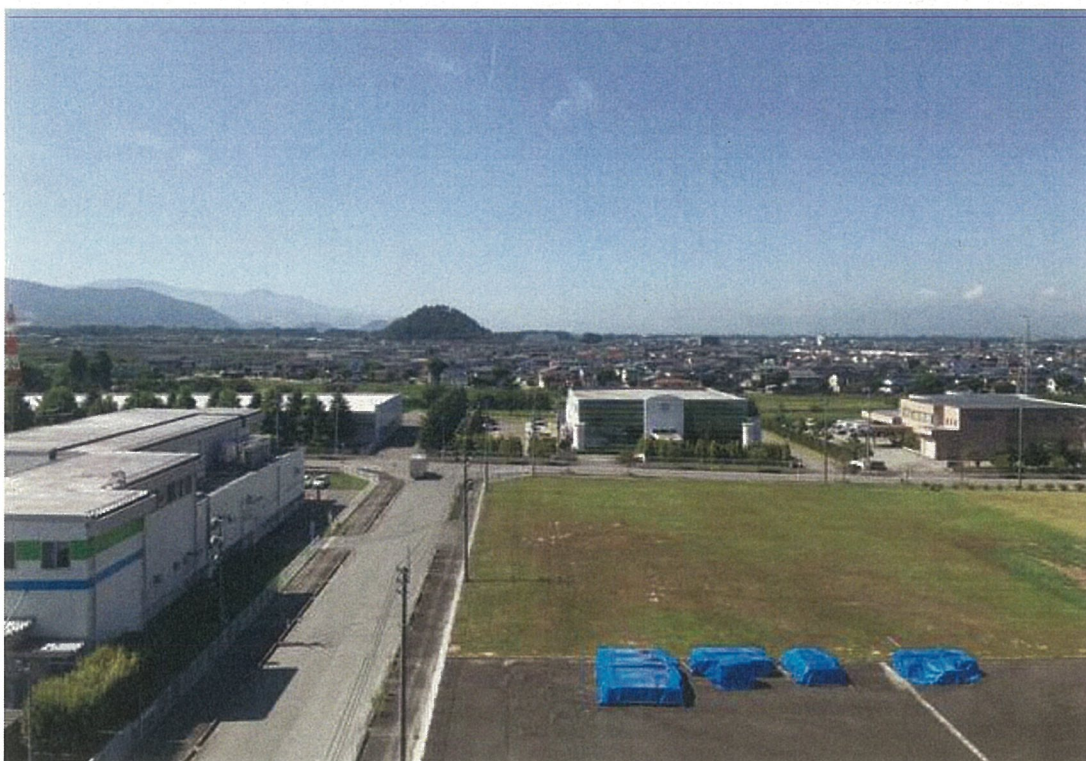
構内北東位置から南側を撮影
