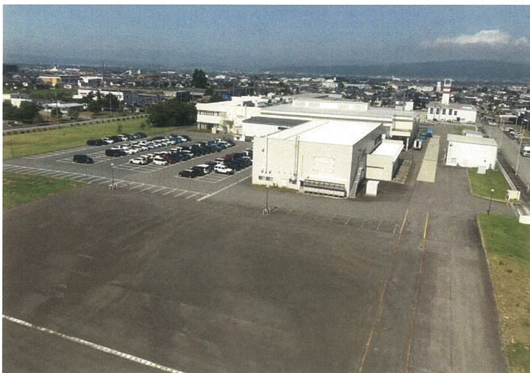
構内北東位置から西側を撮影
