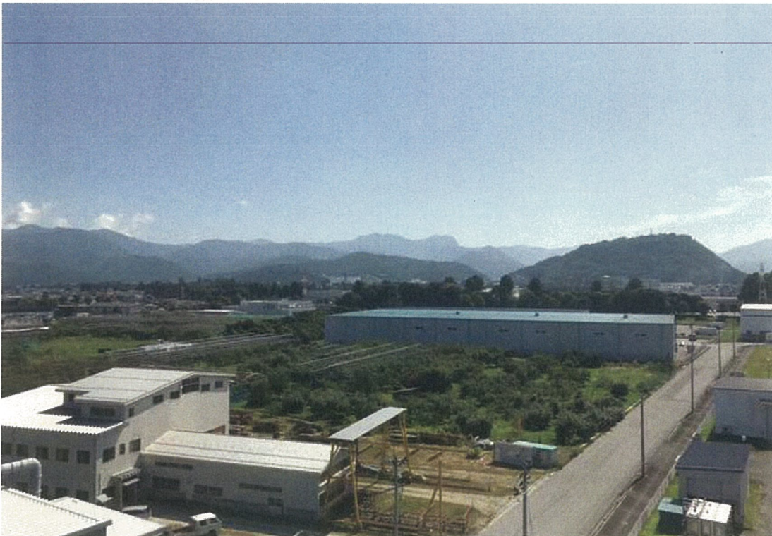
構内北西位置から東側を撮影
