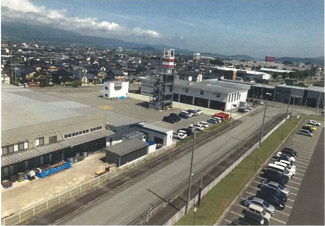
構内南西位置から北西側を撮影
