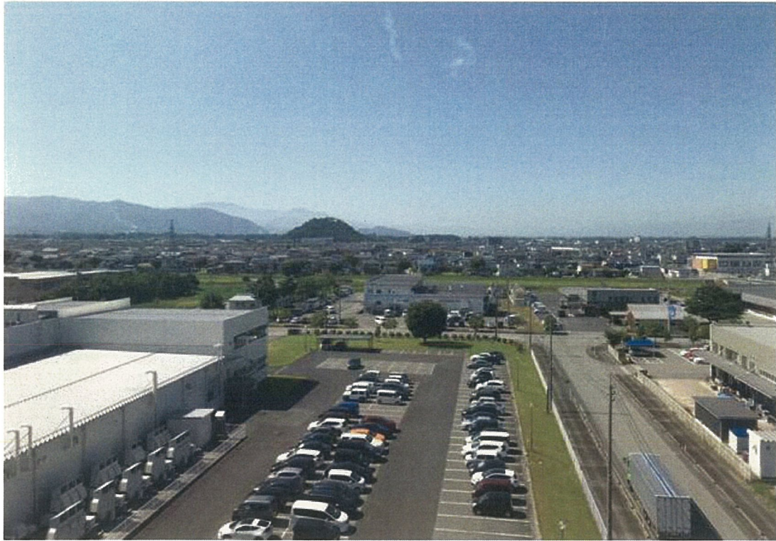
構内北西位置から南側を撮影
