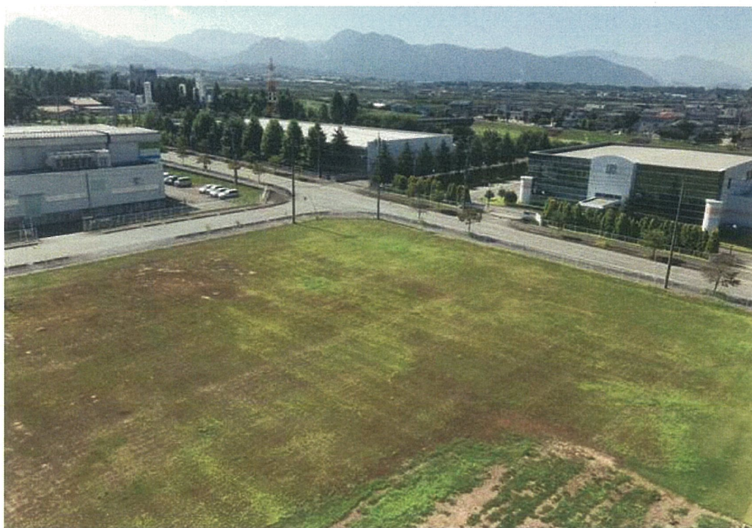
構内中央位置から南東側撮影
