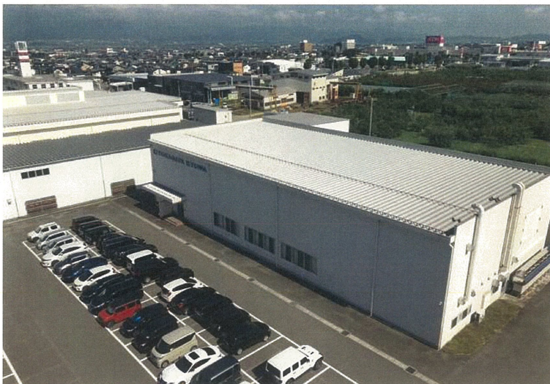
構内中央位置から北西側を撮影 屋根上太陽光設置場所
