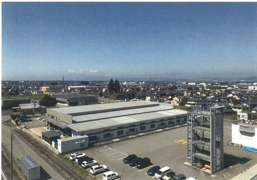
構内北西位置から南西側を撮影
