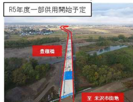
国道287号 (米沢長井道路)
