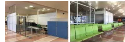
増設した保安検査装置 拡張した搭乗待合室
