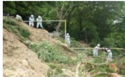
置賜総合支庁職員による被災状況調査
