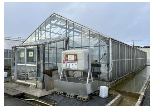
施設園芸用加温ハウス
