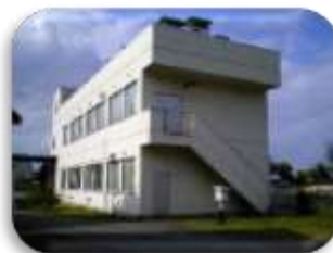
建築環境1号棟 空調実験室
