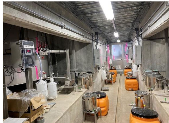
果樹環境制御棟 観測廊(地下部)の様子
