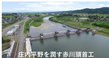
庄内平野を潤す赤川頭首工
