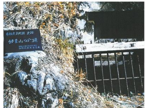
穴堰の取水口付近
