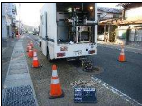
管渠点検調査 (テレビカメラ調査)
