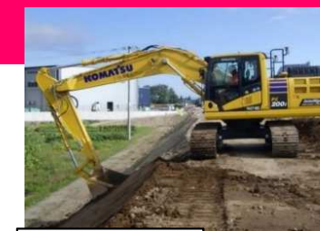
ICT施工の例
