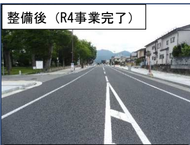
整備後（R4事業完了） 道路拡幅、無電柱化の例 四日町山家町線（山形市）
