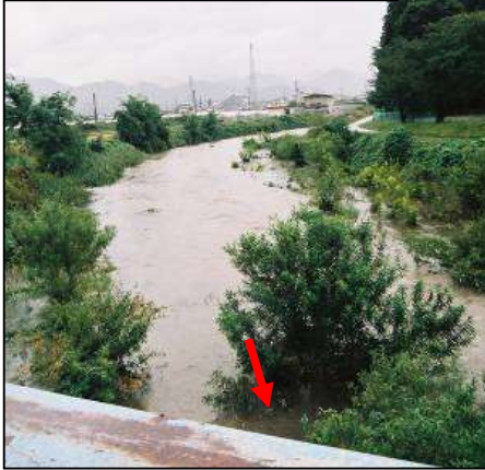
野呂川 ④農道橋より上流を望む 平成18年10月7日大雨 出水状況
