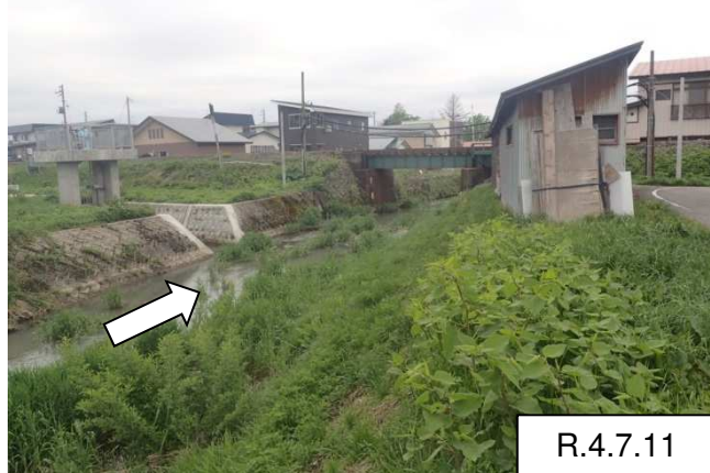
改良前状況 (NO.84付近)
