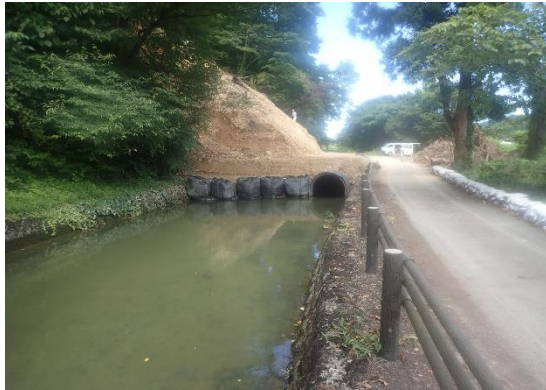
北楯大堰の仮設水路（庄内町清川）
