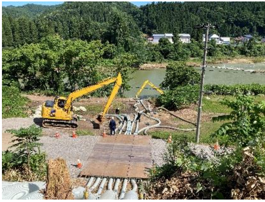
三光堰用水路での応急ポンプ設置（舟形町長沢）
