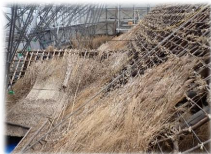
文化財の保存修理の様子
