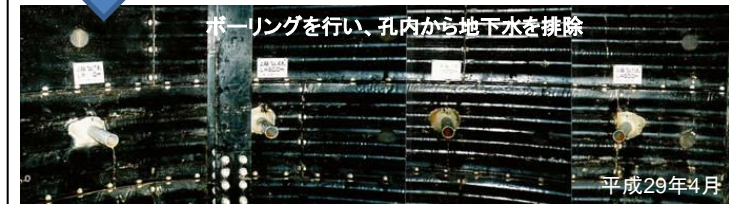
集水井工完成写真(井戸内部の状況)
