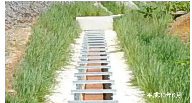
水路工完成写真(地表水を排除)
