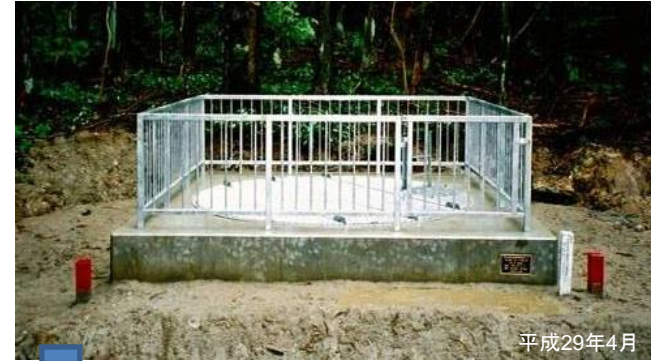
集水井工完成写真(地表の状況)
