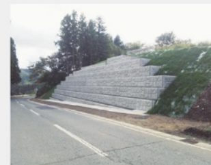
道路改良工事(箱型擁壁)
