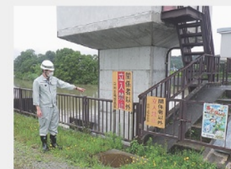
水利施設点検
