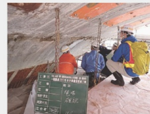
橋梁補修工事現場確認中
