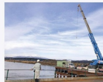
橋梁工事の状況確認
