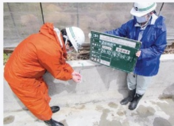
水路工事の完成検査
