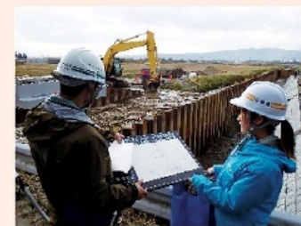
業者との現場確認
