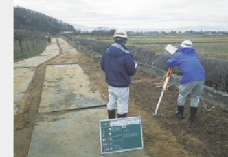
工事段階確認中
