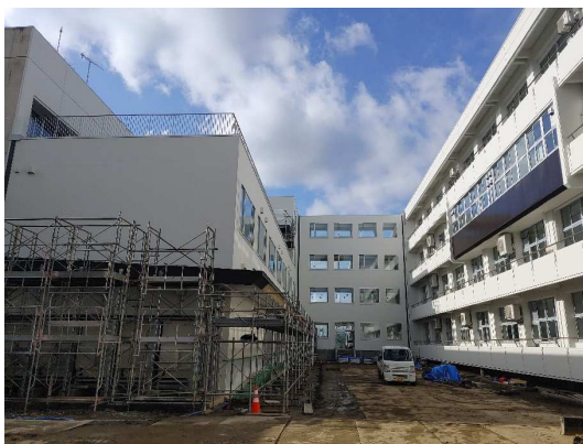
改修中の 致道館高校 ▶
