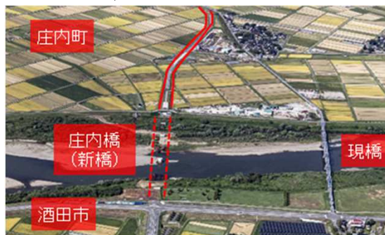
(一)余目松山線（庄内橋）
