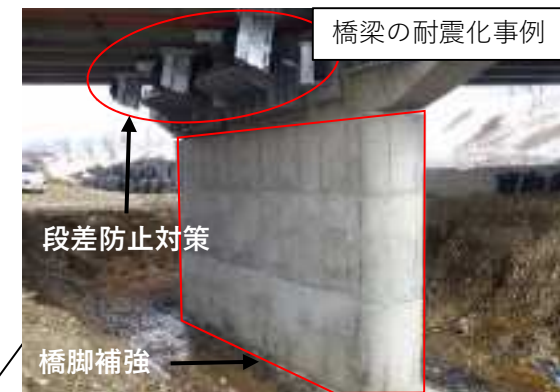
国道458号（升形橋）
