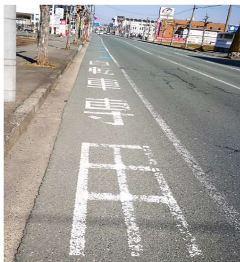
自転車専用通行帯 市道小立街道線（山形市）
