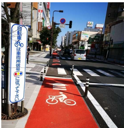
自転車道 国道112号（山形市）
