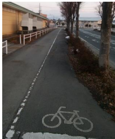
市道北江米沢線 (寒河江市)
