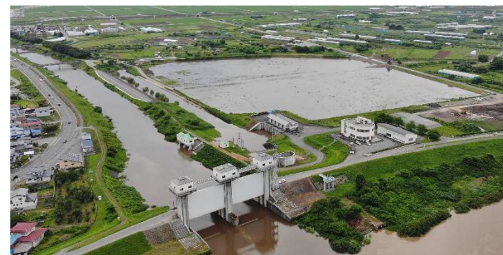
令和5年6月28日の大雨時の調節池の貯留状況 (令和5年6月29日撮影)
