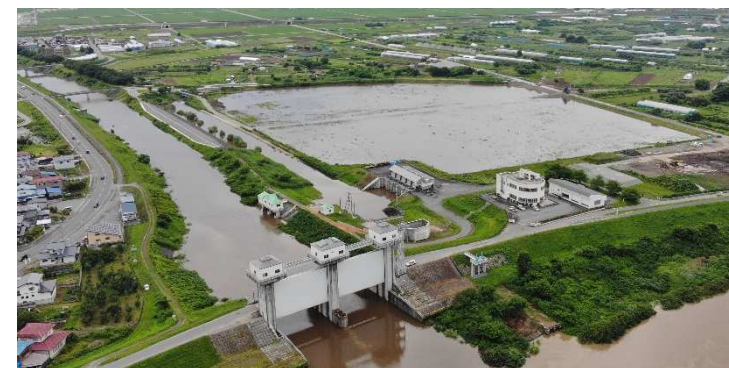
令和5年6月28日の大雨時の調節池の貯留状況 (令和5年6月29日撮影)
