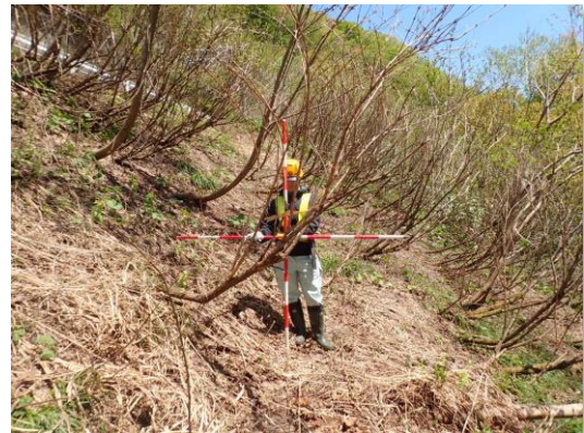
法面の点検状況
