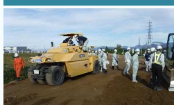
ICT・UAV研修状況
