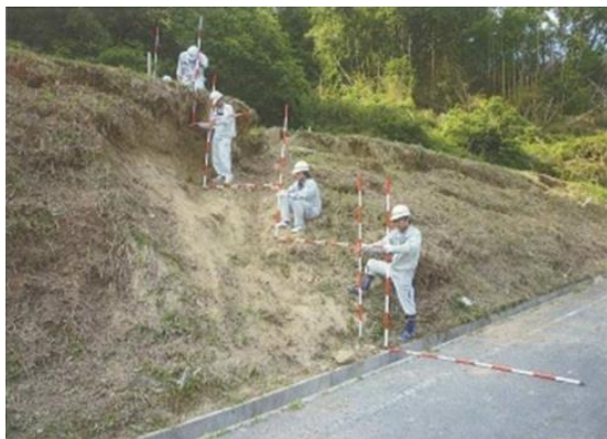
災害発生後の現地調査状況
