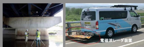
橋梁点検の新技術活用
