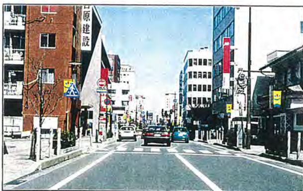
タイルやパネル等の建材による街並みの色彩。こうした街並みは、色彩のみでコントロールすることは困難である。地域の景観計画等として、規模や形態とともに、総合的に計画することが重要である。(山形市)
