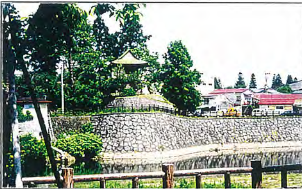
城下町の河川に設置された護岸。既存の鐘撞き堂を保全するため河道を緩やかに屈曲させている。護岸の石積みの方法は近接する城址の石垣を範としており、地区全体としての落ち着いた佇まいを演出している。（横手市）
