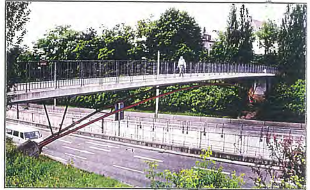
道路を横断するオーバブリッジ。橋桁やトラス、フェンスの部材を細くすることで、透過性が高まり、橋梁の軽快なイメージを演出している。トラス部分に、彩度の高いレッド系の色を用いているが、明度を抑えているため、周辺の緑地から浮き立ち過ぎず、景観の中で適度なアクセントとなっている。
