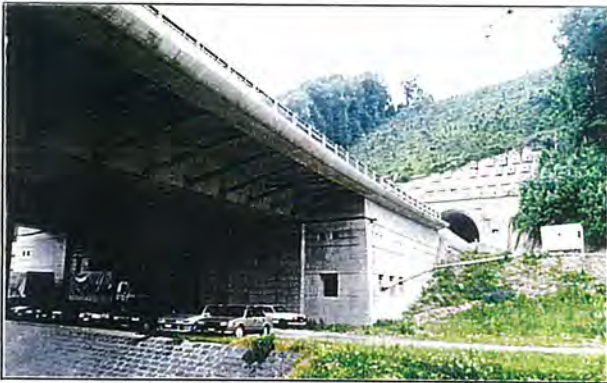
橋桁や橋脚にはコンクリートを用い、高欄部分には彩度が低いグレー系の色が用いられている。橋桁の下部の塗装が必要なスチール部材は、施設に占める割合が低く、外部からは目立たないため、彩度の高いブルー系の色を用いてアクセントとしている。
