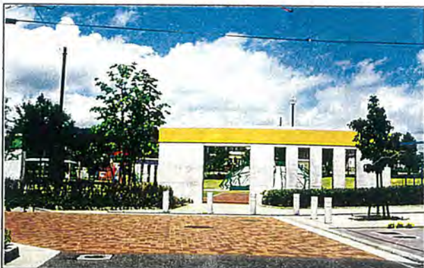
街区公園内の入口部に設置されたゲート。柱にコンクリートを用い、屋根に彩度、明度の高い色を選択している。周辺街区の街並みとしての統一感を妨げない程度に、主な利用主体である子供たちの意識を向けさせるような色づかいも考えられる。(仙台市)
