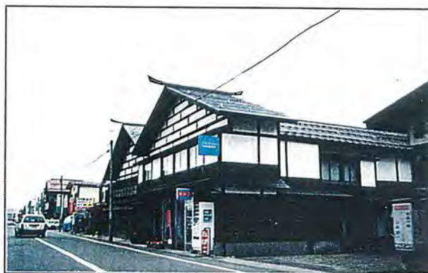
地域の伝統的な素材を用いて建築された住宅。新建材や塗装によって地域の素材の色を再現するのではなく、地域に伝統的に使われてきた素材を用いることが、地域の色彩の表現につながる。(金山町)
