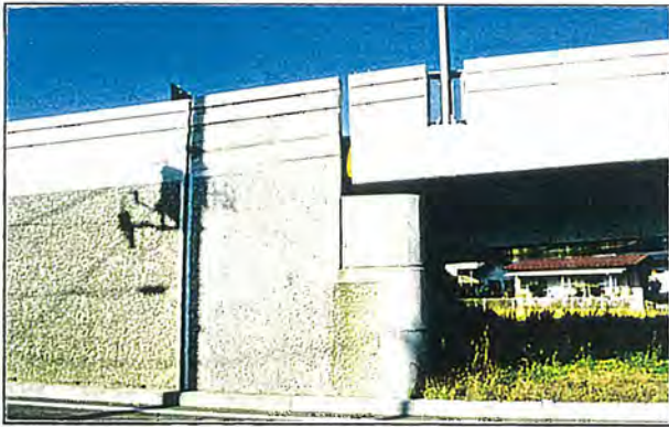
コンクリート製高架橋の橋台。面の分割により一様な面に変化を与え、さらに、はつり仕上げとすることで輝度を下げている。（福島市）
